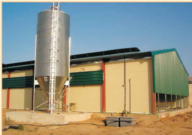
Frontal con paneles de refrigeración —"coolings"— protegidos.
