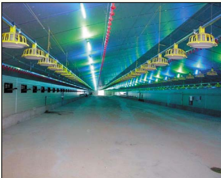
Vista general del interior de la nave.
