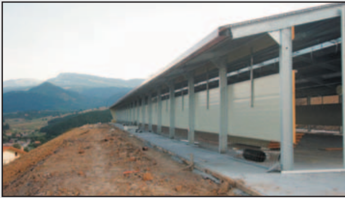
En la primera foto, se puede ver cómo se han colocado los paneles sandwich en los cerramientos laterales. En la segunda, los paneles en el piñón posterior de la nave y el hormigonado del suelo circundante. Fotos de Esteban Atxa Calvo
