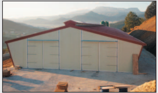
En la primera foto, se puede ver cómo se han colocado los paneles sandwich en los cerramientos laterales. En la segunda, los paneles en el piñón posterior de la nave y el hormigonado del suelo circundante. Fotos de Esteban Atxa Calvo
